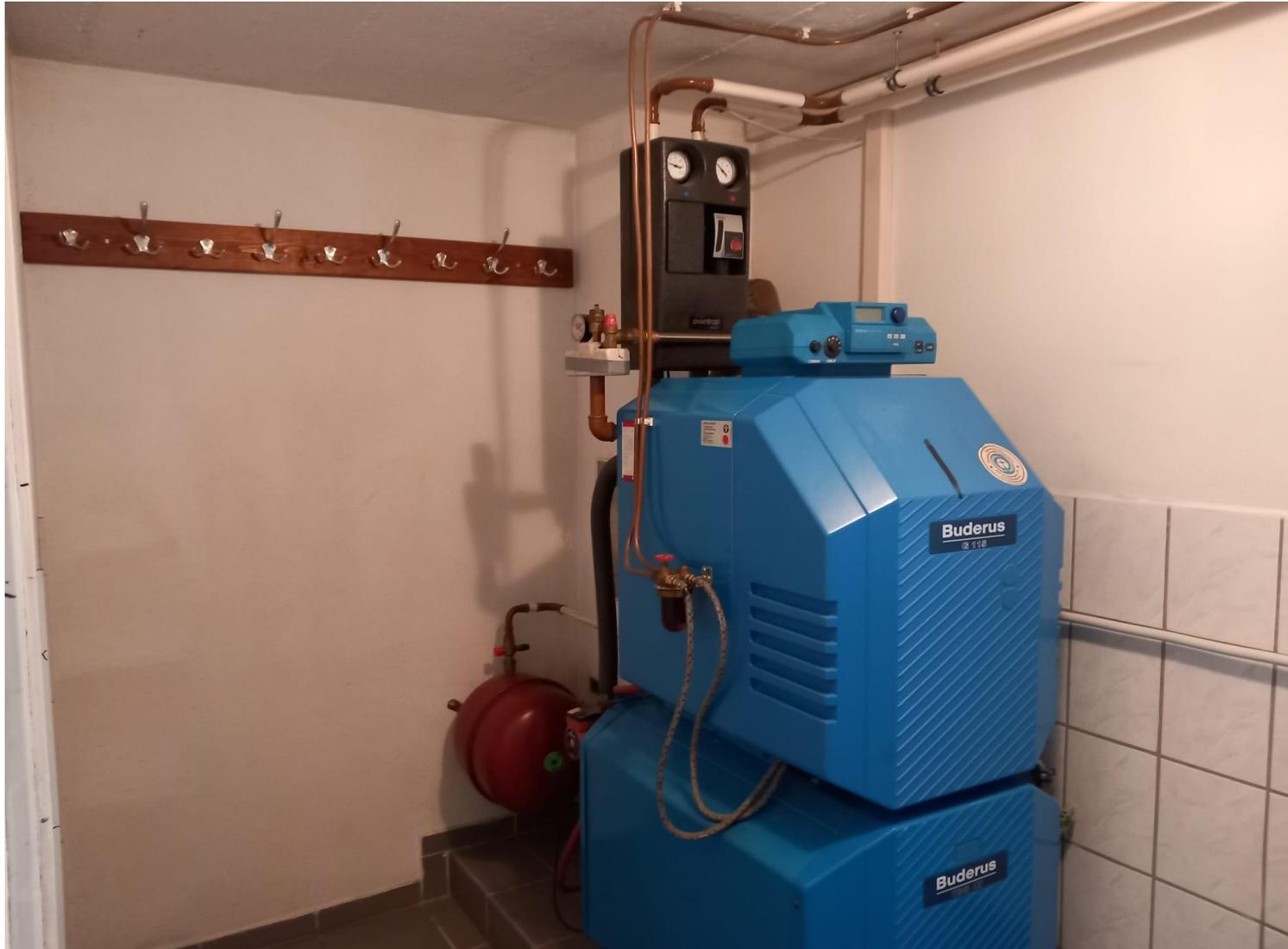
Nachher: Nahwärme-Übergabe mit Pufferspeicher, Pumpengruppe, Frischwasserstation und Regelung
